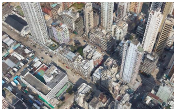
Existing Low Rise Cluster near Hi Lung Lane 現時熙龍里一帶低矮建築群
